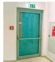
Panikstange (Quelle: Berufsgenossenschaft Handel und Warendistribution [BGHW])
